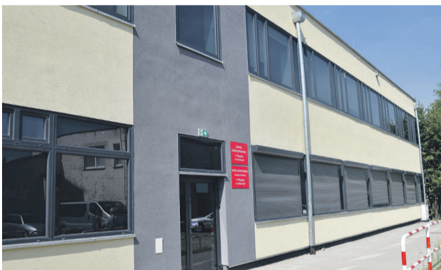
▲ Wyremontowany budynek Zespołu Szkolno-Przedszkolnego w Długołęce
