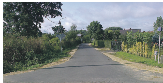
▲ Przebudowana droga w miejscowości Wabienice
