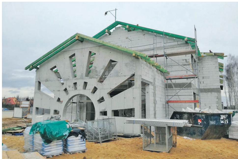
▲ Budowa przedszkola gminnego w Dobroszycach.
